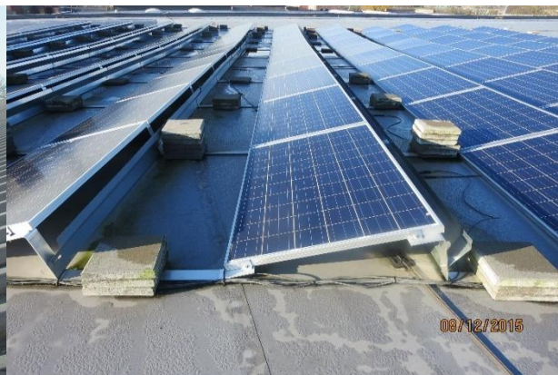
Kabels onder de daklast en water in het midden van het dak
